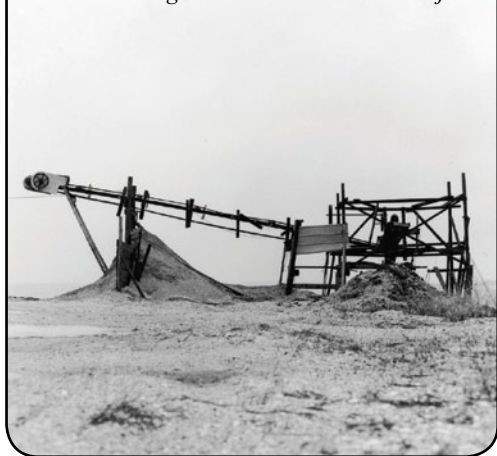
Skallegravemaskine ved Odense Fjord
